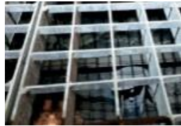
Reja no descontaminada tras una proyección química
